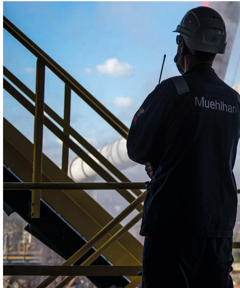
Mitarbeiter der Muehlhan Cyprus Limited in einer Raffinerie
