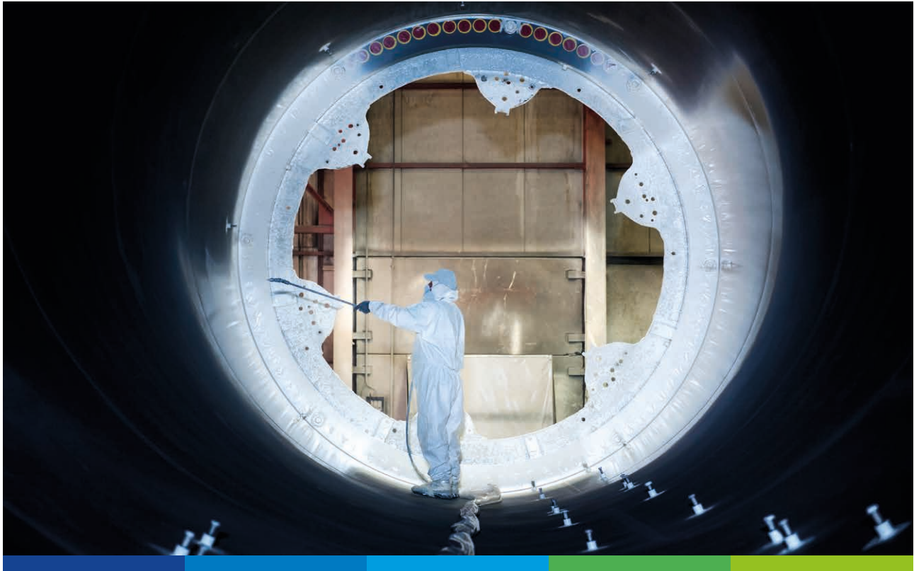
Beschichtungsarbeiten an einem Windturbinenturm
