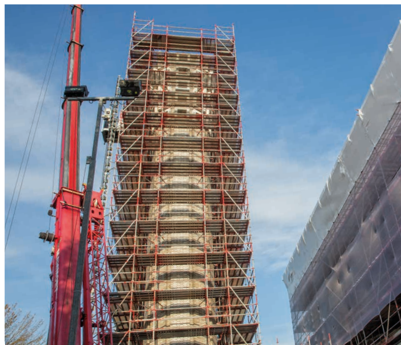
Gerüstbauarbeiten an einer Industrieanlage
