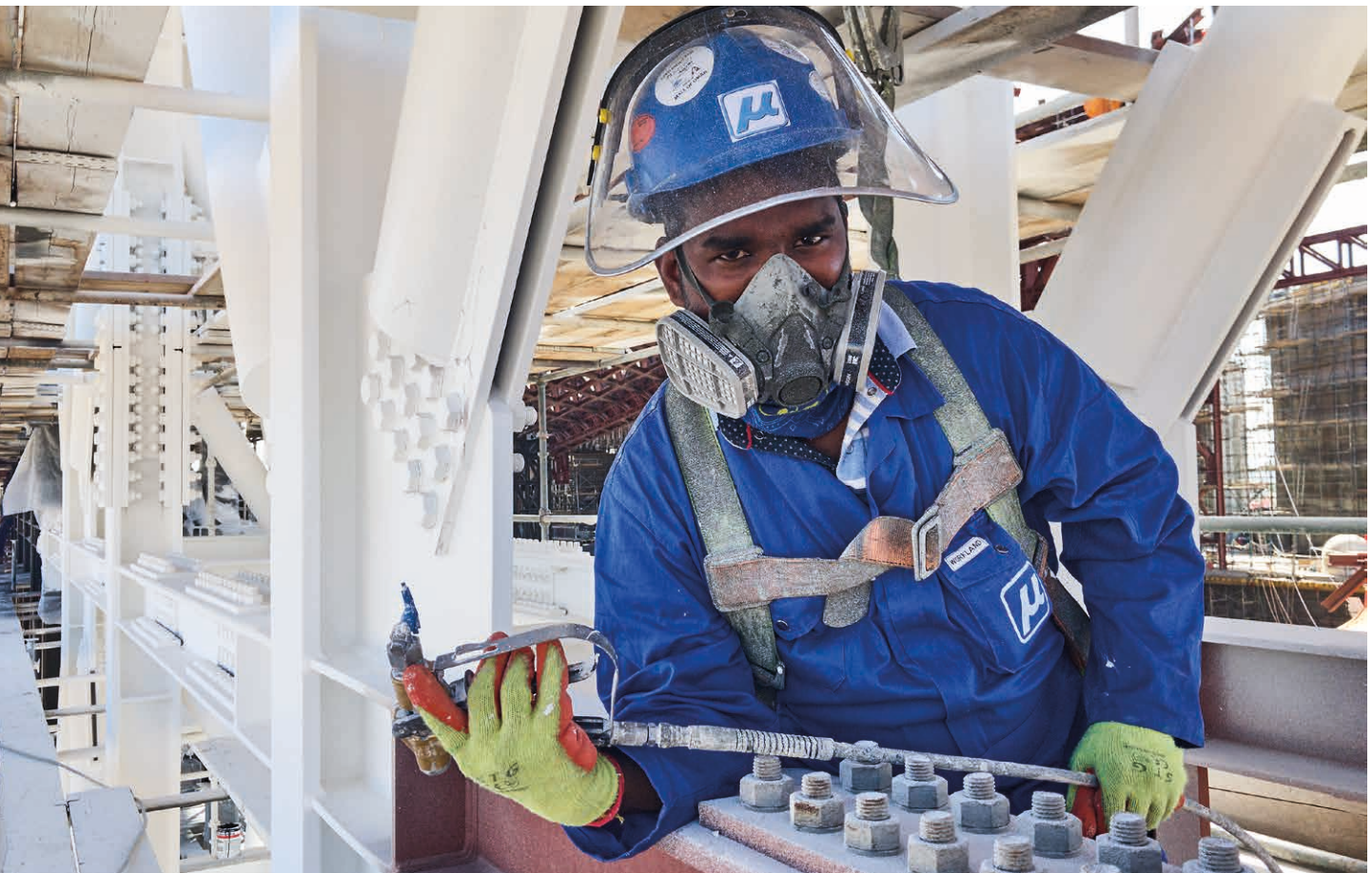
Aufbringen von passivem Brandschutz
