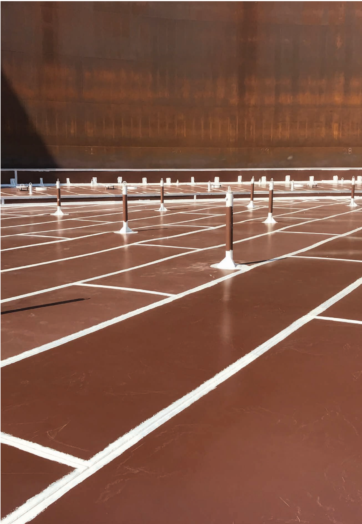
Vorbereitung von Oberflächenschutzarbeiten
