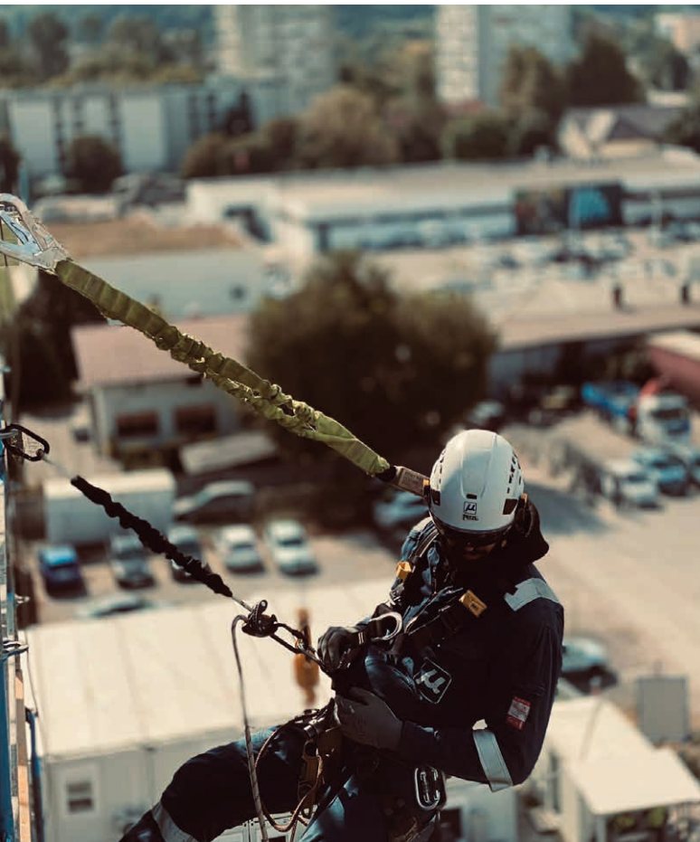
Zugangstechnik im Hochbau
