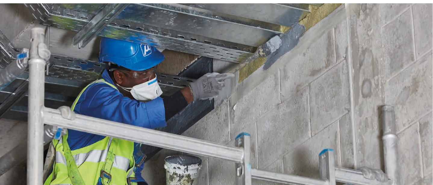
Aufbringen von passivem Brandschutz
