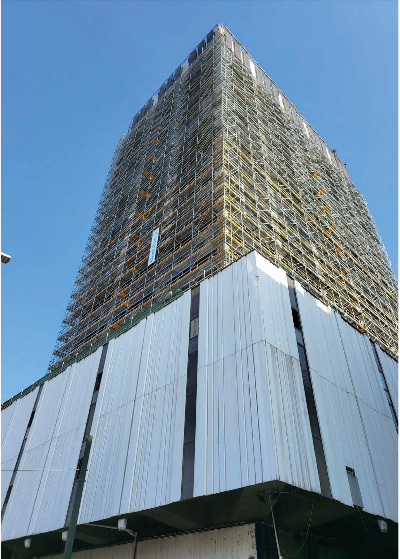
Einrüstung eines Hochhauses
