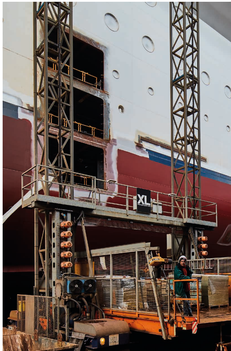
Aufbringen von Oberflächenschutz
