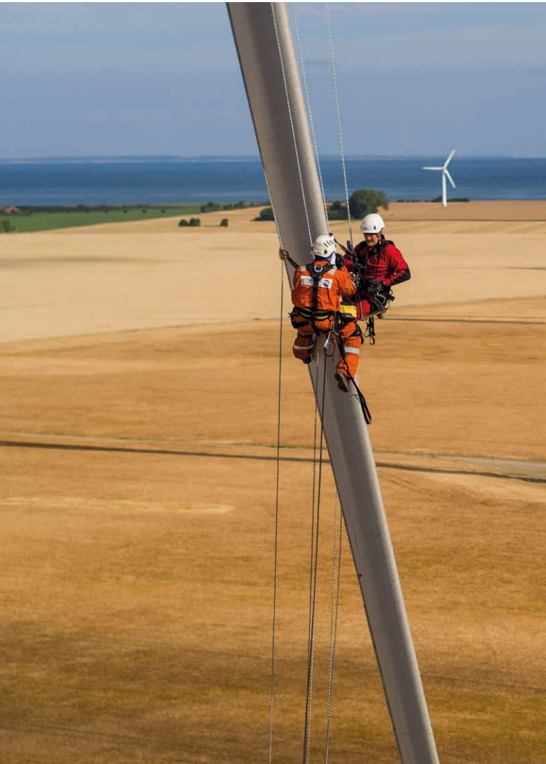
Inspektion von Rotorblättern an Windkraftanlagen
