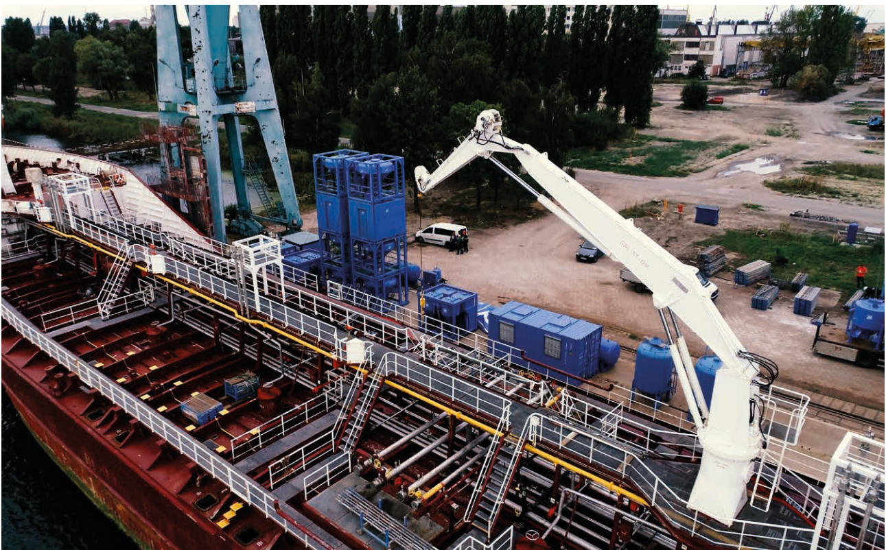
Tankbeschichtung am Schiff „Orahholm“
