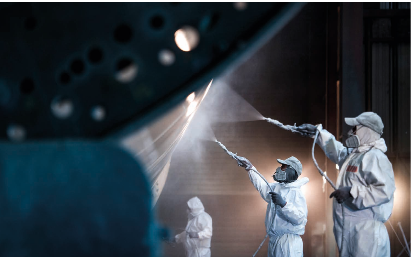
Aufbringen von Oberflächenschutz an einen Schiffsrumpf
