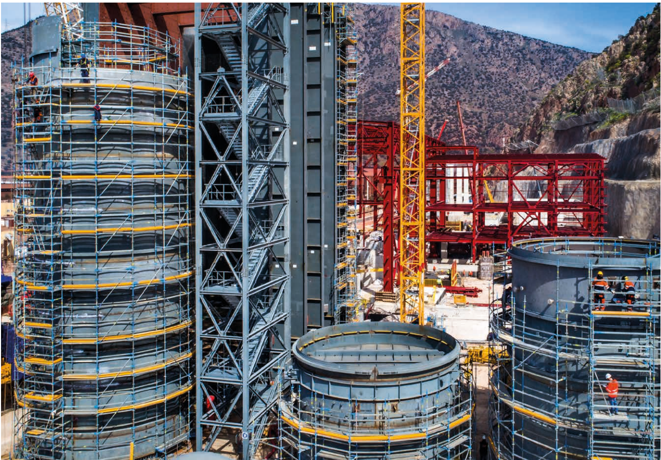
Gerüstbauarbeiten an einer Industrieanlage
